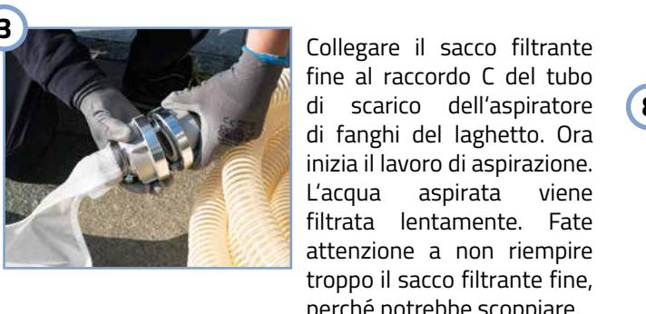
Collegare il sacco filtrante fine al raccordo C del tubo di scarico dell'aspiratore di fango del laghetto. Ora inizia il lavoro di aspirazione. L'acqua aspirata viene filtrata lentamente. Fate attenzione a non riempire troppo il sacco filtrante fine, perché potrebbe scoppiare.
