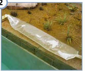
Feinfiltersack ausbreiten und in die Regenerationszone legen. Achten Sie darauf, dass keine spitzen Steine oder Gegenstände unter dem Feinfiltersack liegen.
