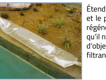
Étendre le sac filtrant fin et le placer dans la zone de régénération. Veillez à ce qu'il n'y ait pas de pierres ou d'objets pointus sous le sac filtrant fin.
