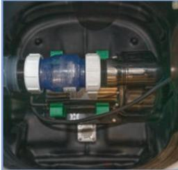
Rückschlagventil und Schmutzwasserpumpe Torpedo
