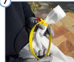
Placez le serre-câble autour de l'extrémité pliée du sac et serrez-le fermement.
