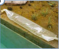
Feinfiltersack ausbreiten und in die Regenerationszone legen. Achten Sie darauf, dass keine spitzen Steine oder Gegenstände unter dem Feinfiltersack liegen.
