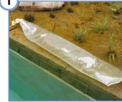
Étendre le sac filtrant fin et le placer dans la zone de régénération. Veillez à ce qu'il n'y ait pas de pierres ou d'objets pointus sous le sac filtrant fin.
